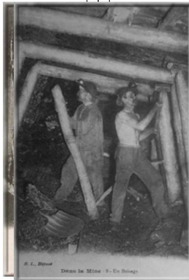
Pendant longtemps, le bois a été utilisé. Puis, la modernisation remplaça progressivement les cadres en bois par des cintres métalliques qui avaient l'avantage de pouvoir se déformer quand un terrain travaillait. Deux genres de soutènement métallique étaient utilisés : le cintre Clément constitué en deux parties, le cintre Toussaint-Heintzmann en trois parties. Ce type d'étaisage, lors de la taille, faisait appel en outre à des étaçons. Une page des locataires des ténèbres se tournait...
